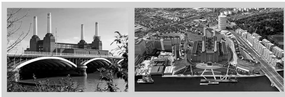
Рис. 4. Здание Battersea Power Station, Лондон
