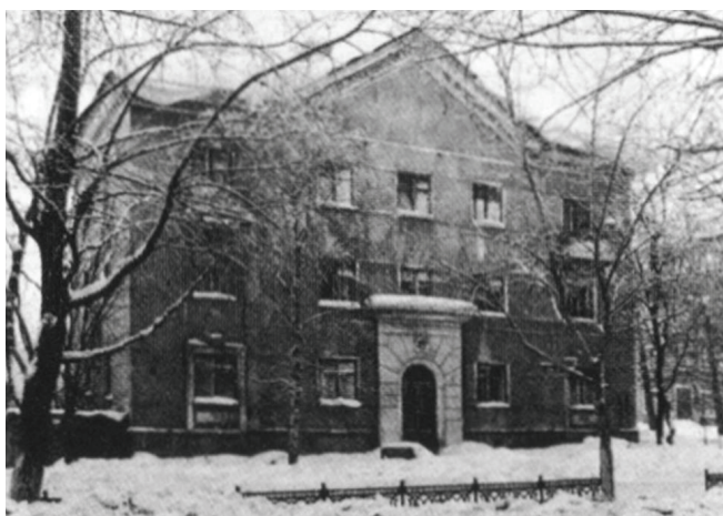
Рис. 2. Первый полносборный жилой дом
