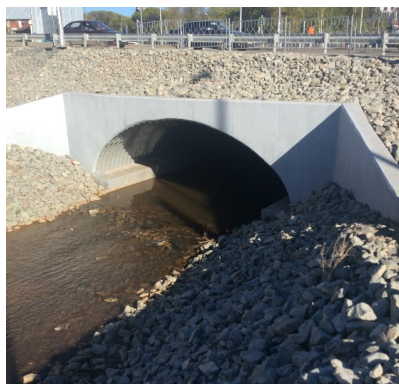
Рис. Водопропускное сооружение из металлических гофрированных структур
