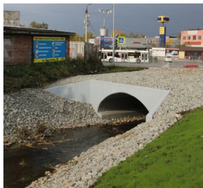
Рис. Водопропускное сооружение из металлических гофрированных структур
