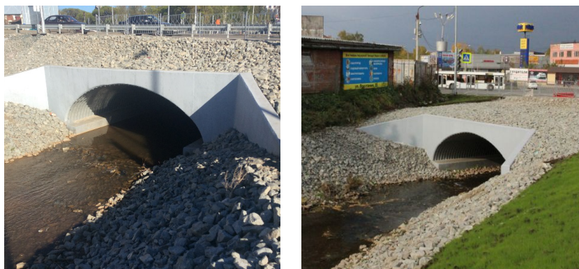
Рис. 1. Водопропускное сооружение из металлических гофрированных структур
