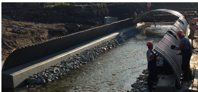
Рис. 10. Применение гофрированной конструкции пониженного типа (производитель – ООО «ВиаКон Сейфрод») в г. Перми, объект «Реконструкция площади Восстания»
