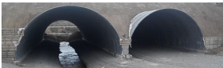
Рис. 11. Применение гофрированной конструкции круглого очертания (трасса М5 «Урал»)
