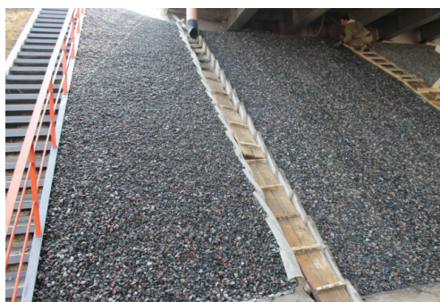
Рис. 4. Окончание работ по ремонту конуса путепровода
