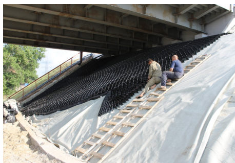
Рис. 2. Устройство нетканого текстиля и новой объемной георешетки
