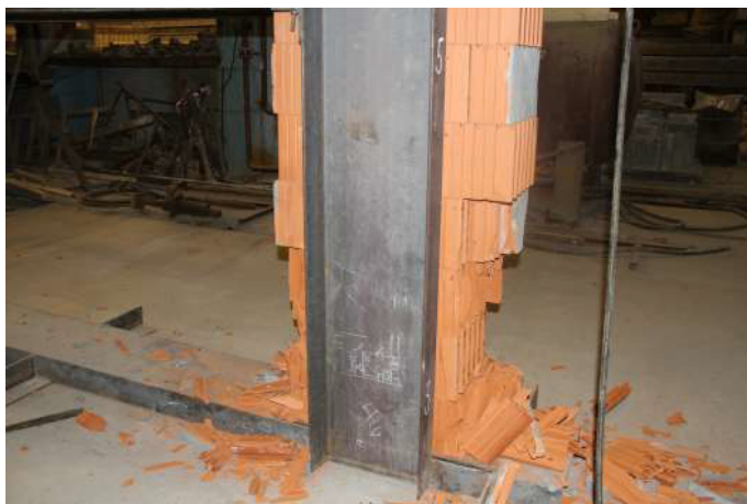
Рис. 4. Разрушение нижних рядов стеновой панели при приложении нагрузки 3,47 МПа
