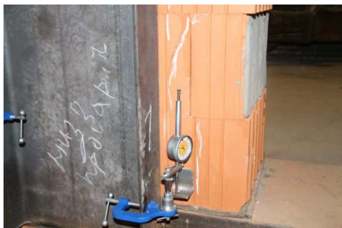
Рис. 6. Вертикальные трещины в камнях стеновой панели, ширина раскрытия до 1,5 мм
