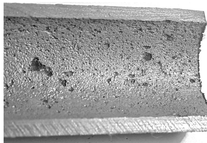
Рис. 2. Вид повреждения с внутренней стороны труб змеевика экономайзера (после химической очистки)
