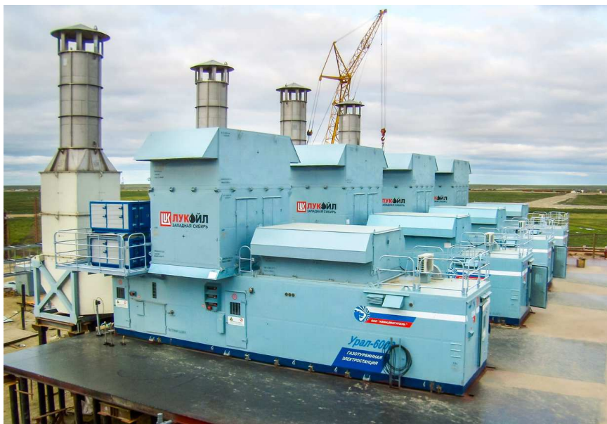
Рис. 2. Внешний вид электростанции Урал-6000 мощностью 6 МВт [12]
