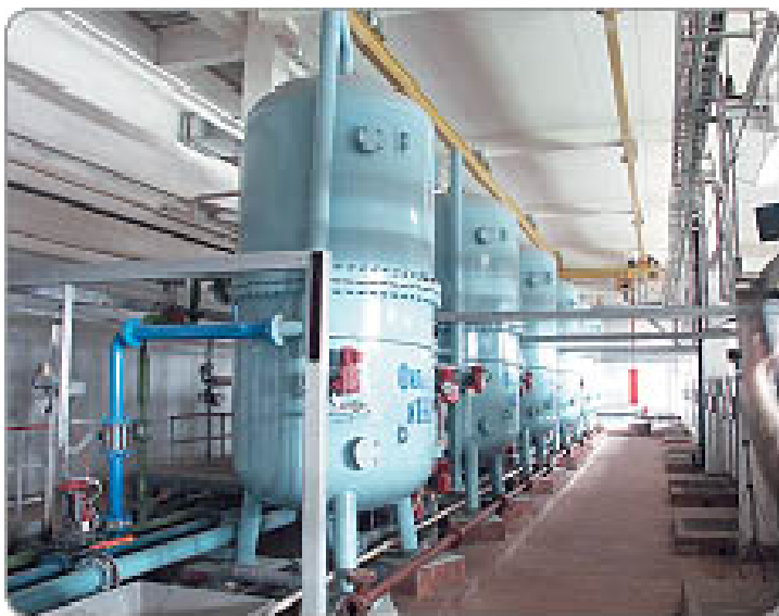
Рис. 4. Противоточные Na-катионитные фильтры на тепловой станции «Люблино» в ГУП «Мостеплоэнерго»
