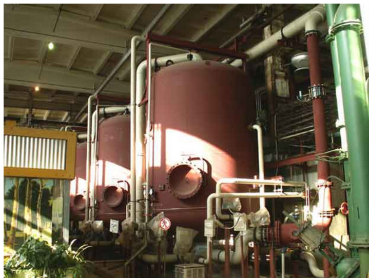
Рис. 3. Противоточная ионообменная установка
