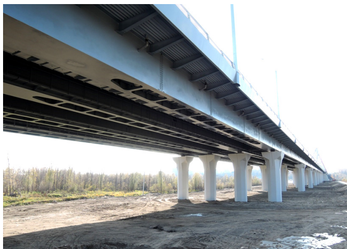
Рис. 2. Конструкция пойменных пролетных строений Бугринского моста (правобережный участок)
