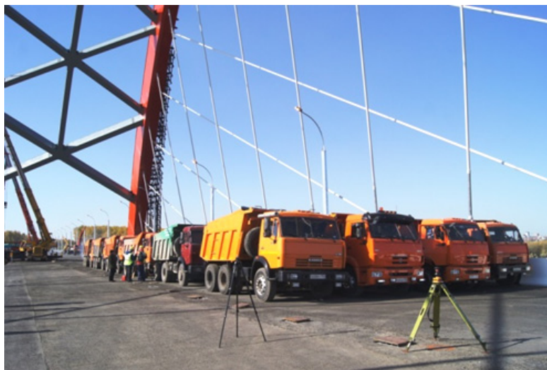
Рис. 7. Установка испытательной нагрузки на мосту
