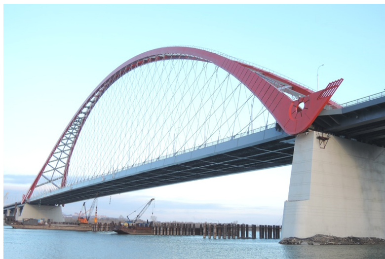
Рис. 3. Главное русловое пролетное строение Бугринского моста
