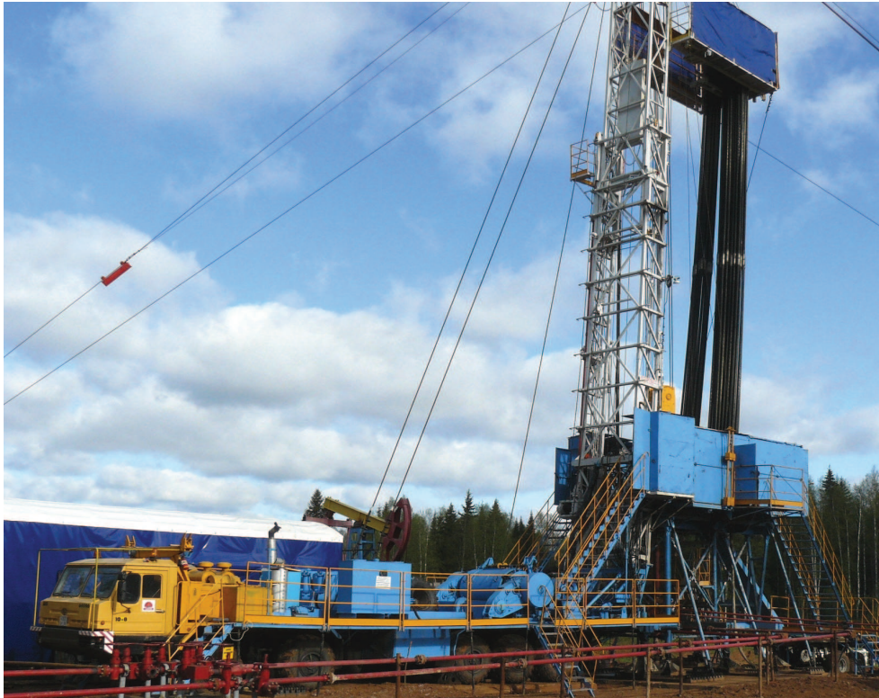
Рис.1. Мобильная буровая установка АРБ-100
