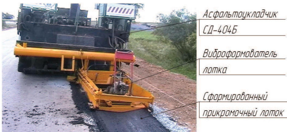
Рис. 6. Агрегат для изготовления прикромочных водоотводных лотков из асфальтобетона в действии
