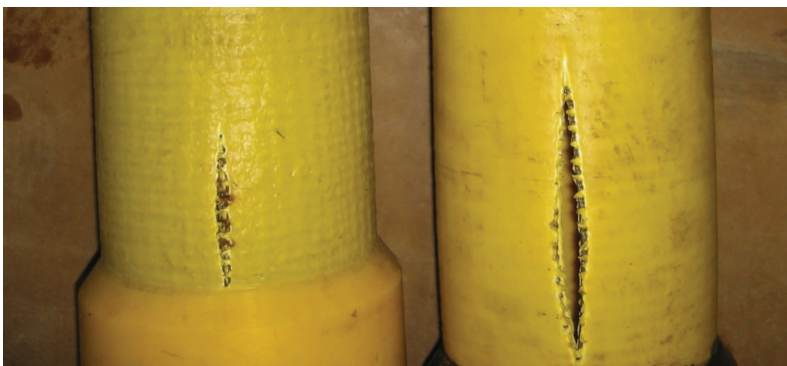
Рис. 1. Разрушение газовой трубы. Слева под воздействием статического нагружения, справа под воздействием динамического нагружения.
