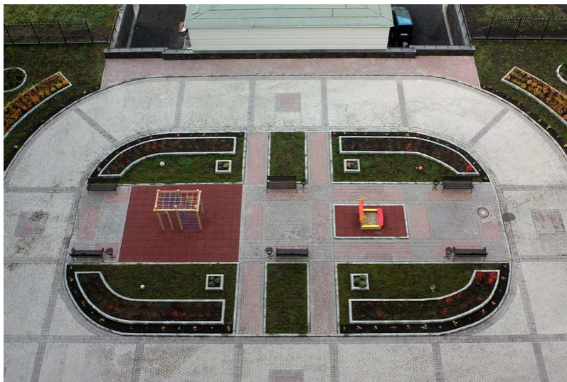
Рис. 14. Эксплуатируемая кровля. Детская площадка, г. Санкт-Петербург ( http://dizainstroyspb.ru/fotogalereya.html?album=1&gallery=3 )
