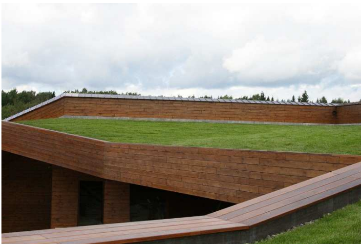
Рис. 13. Подземная галерея в Дмитровском районе Московской области
