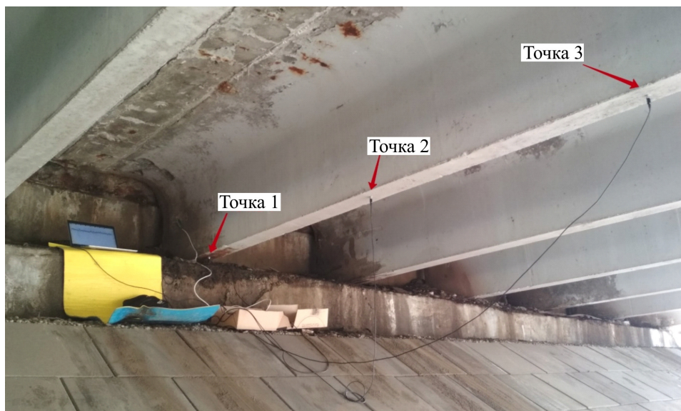
Рис. 2. Установка измерительных преобразователей в трех точках на нижней грани ребра балки пролетного строения для реализации виброаналитического метода диагностики состояния деформационного шва
