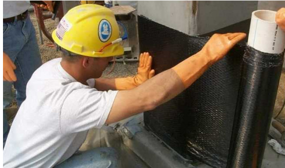
Рис. 13. Процесс внешнего армирования строительной конструкции ПКМ
