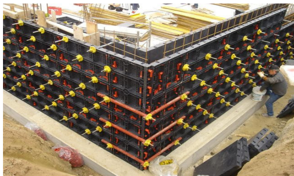
Рис. 17. Опалубка для бетонирования стен из ПКМ
