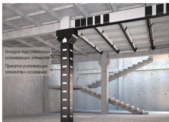
Рис. 12. Внешнее армирование строительных конструкций углепластиком
