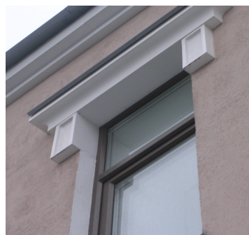
Рис. 20. Элементы стеклопластиковой лепнины над окнами дома
