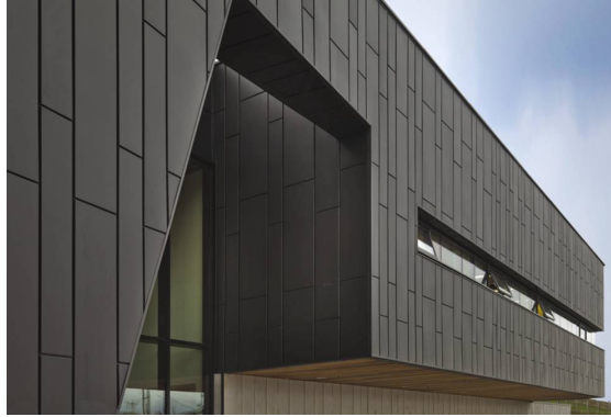
Рис. 15. Внешняя отделка здания из углепластика
