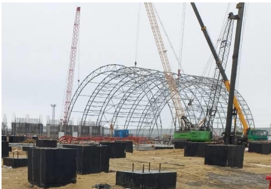
Рис. 1. Строящийся склад сырых окатышей
