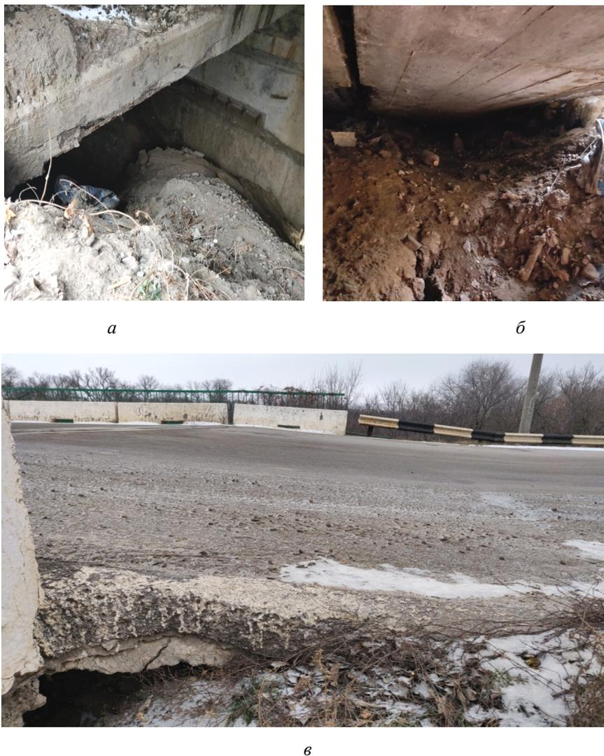
Рис. 1. Дефекты устоя: *а* – пустота за устоем; *б* – отсутствует обратная засыпка на всей площади плит мягкого въезда и на всю высоту устоя; *в* – просадка асфальтового покрытия
