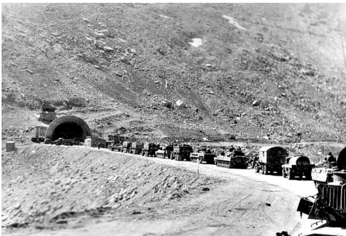
Рис. 2. Колонна советской боевой техники входит в тоннель
