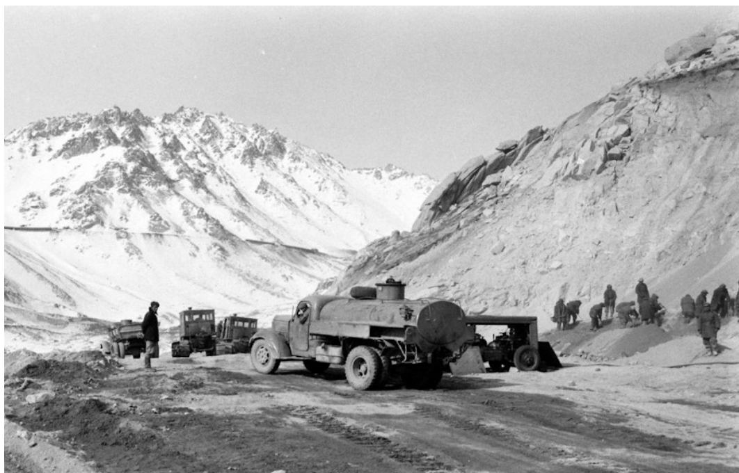
Рис. 1. Строительство дороги на перевале Саланг. На фото в центре видны советские самосвалы, бульдозеры, бензовозы и компрессоры. Справа – афганские солдаты
