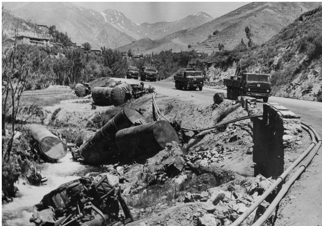
Рис. 4. По дороге, ведущей к тоннелю, движется колонна советских машин. Слева, на берегу реки – 7 сгоревших бензовозов, уничтоженных моджахедами и сброшенных с дороги. По обочине дороги тянутся две ветки трубопровода
