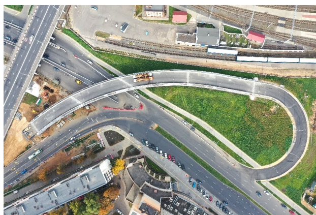
Рис. 1. Общий вид строящегося эстакадного съезда
