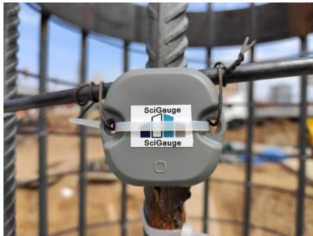
Рис. 12. Высокотемпературная пассивная RFID-метка на рабочей арматуре каркаса стойки
