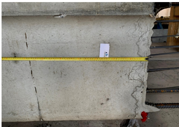
Рис. 11. Расположение высокотемпературной пассивной RFID-метки ISO Card SciVim на поверхности балки
