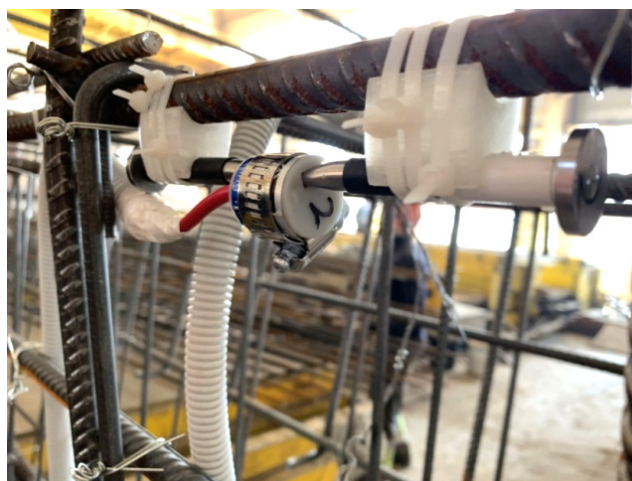
Рис. 9. Установка закладного струнного тензометра SciBim EVW на арматуру каркаса балки
