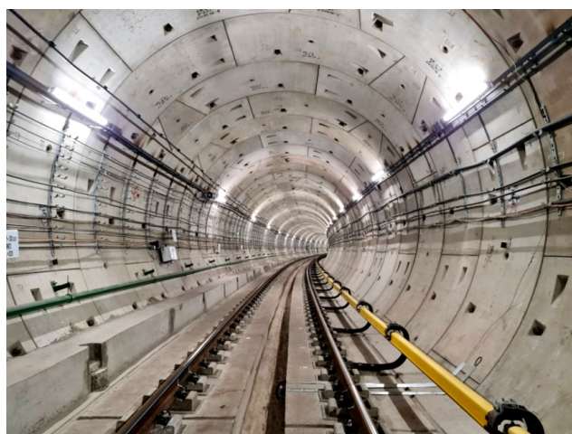
Рис. 2. Общий вид перегонного тоннеля, попадающего в зону влияния строительства эстакадного съезда
