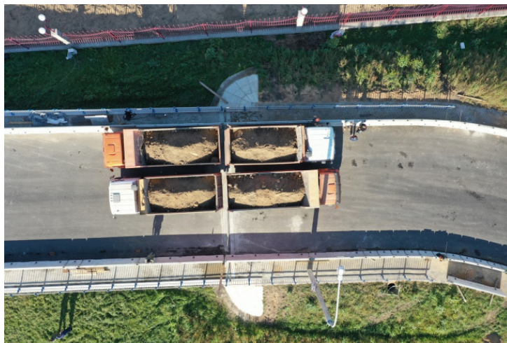
Рис. 13. Установка испытательной нагрузки в зоне крайней опоры эстакадного съезда
