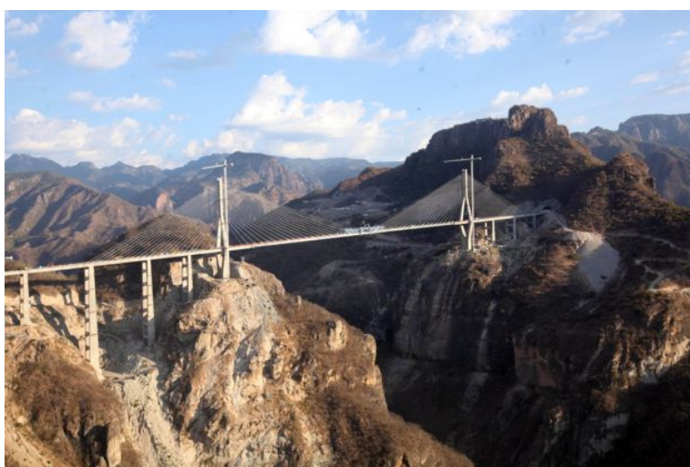
Рис. 1. Использование эстакад в качестве подходных сооружений к вантовому мосту Baluarte, Мексика 1
