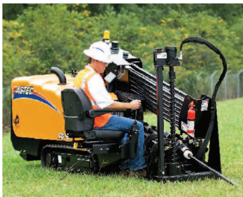
Рис. 2. Работа установки горизонтально направленного бурения
