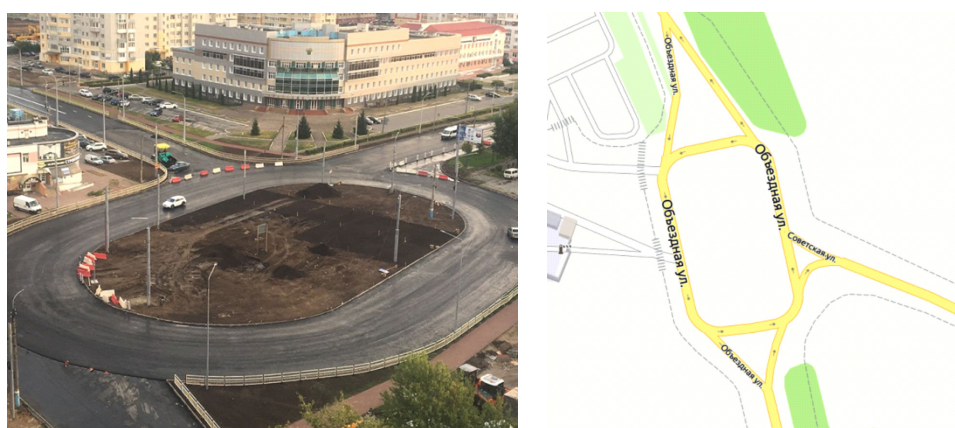
Рис. 3. Примеры строящихся кольцевых развязок в г. Брянске
