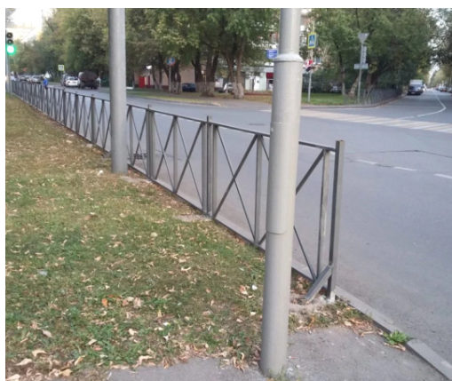
Рис. 4. Металлическое ограждение проезжей части дороги
