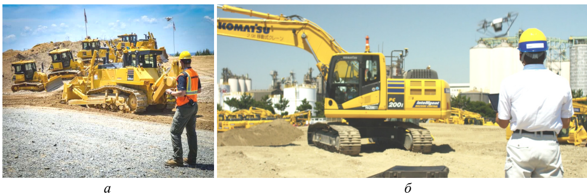
Рис. 1. Работа строительных машин с дроном Skycatch, которым управляет оператор: а – перемещение грунта бульдозер-рыхлителем [12]; б – экскавация грунта одноковшовым экскаватором [13]
