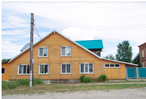
Рис. 7. Жилой дом по ул. Мамина Сибиряка, 2018 год
