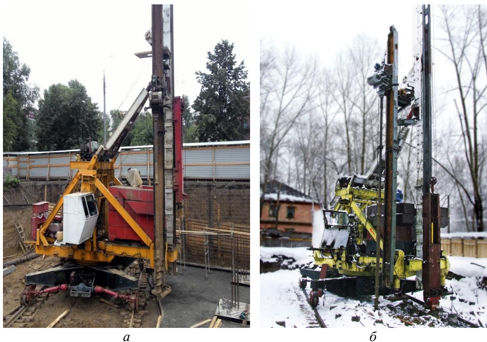
Рис. 1. Общий вид сваевдавливающей установки (СВУ) на строительных площадках в г. Томске: а, б – соответственно по ул. А. Иванова, 2 (май 2014 г.) и ул. Косарева, 14 (ноябрь 2013 г.)
