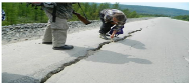
Рис. 2. Трещины на проезжей части дороги с твердым покрытием на участке устья р. Большой Ключ. Фото С.И. Серикова, 2015 г.
