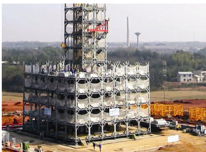
Рис. 4. Отель T30 в Китае на этапе строительства, BROAD Group Fig. 4. Hotel T30 in China, BROAD Group
