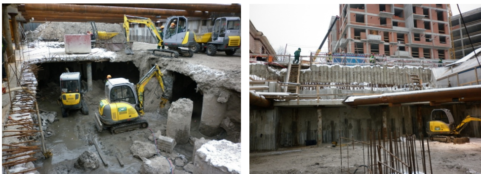
Рис. 6. Устройство подземной части здания областного Арбитражного суда г. Санкт-Петербурга
