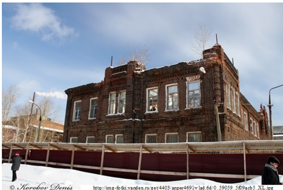
Рис. 5. Здание поселка, 2011 год
