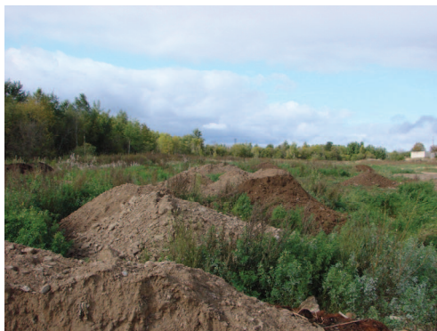
Рис. 4. Полигон размещения строительных отходов в стадии отсыпки
