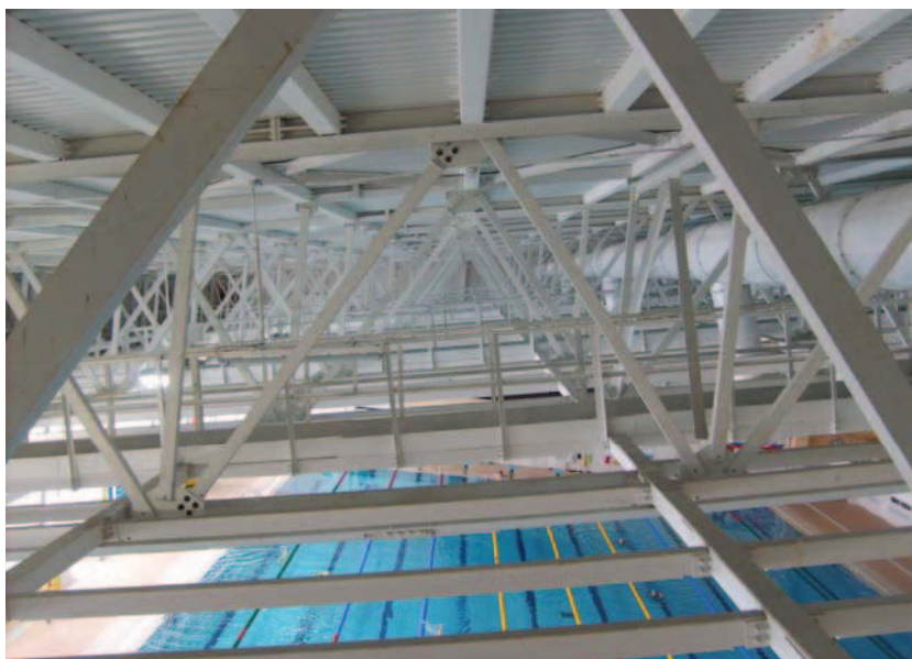
Рис. 1. Общий вид металлоконструкций покрытия спорткомплекса
