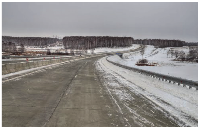
Рис. 1. Автомобильная магистраль с бетонным покрытием [1]
