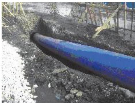
Рис. 3. Протаскивание полиэтиленовой трубы
