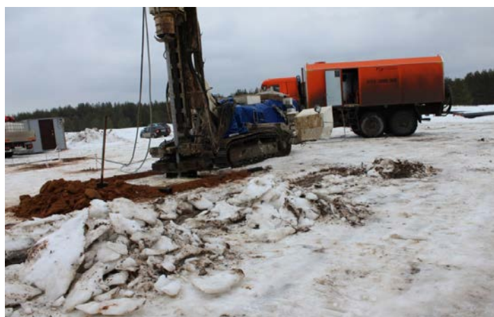
Рис. 1. Оборудование для проведения полевых испытаний
