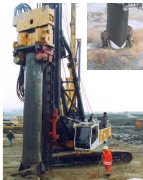
Рис. 2. Установка сваи методом виброзамещения
