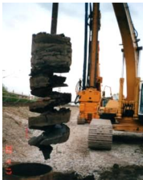
Рис. 1. Установка сваи методом выемки грунта
