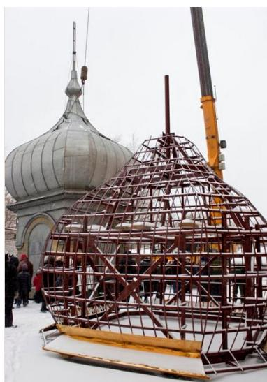
Рис. 6. Новая конструкция купола
