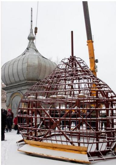
Рис. 6. Новая конструкция купола
