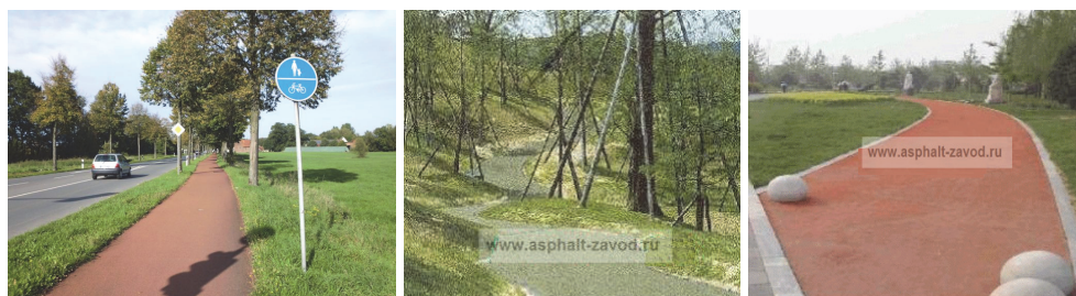
Рис. 1. Велодорожки с покрытием из цветного асфальтобетона
