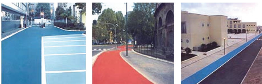
Рис. 5. Покрытия из декоративного бетона
