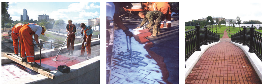
Рис. 6. Технология устройства покрытия Imprint
