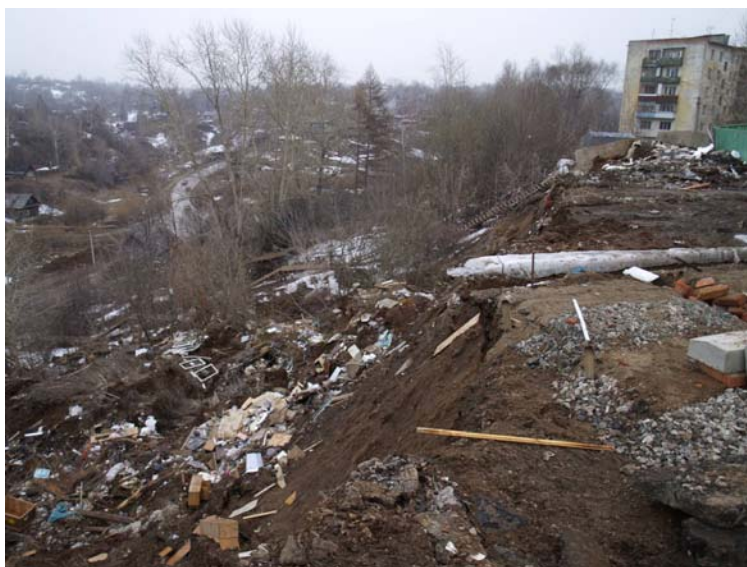
Рис. 2. Разрушение склона в Мотовилихинском районе г. Перми
