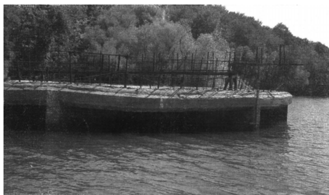
Рис. 3. Общий вид верхней части шахтного водосброса Неберджаевского водохранилища
