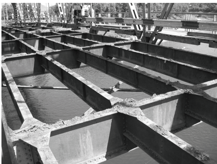
Рис. 2. Балочная клетка после разборки деревянной проезжей части
