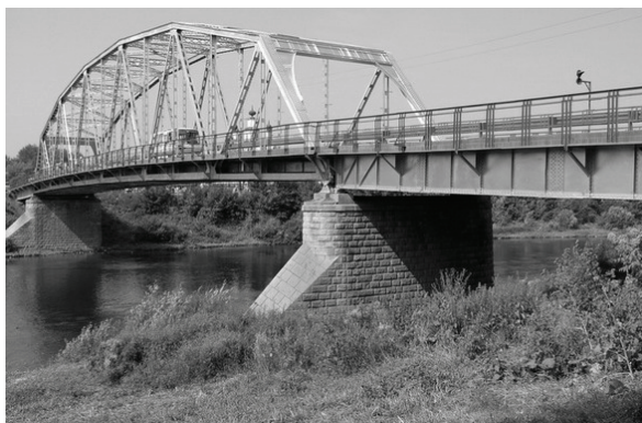
Рис. 1. Вид моста после реконструкции
