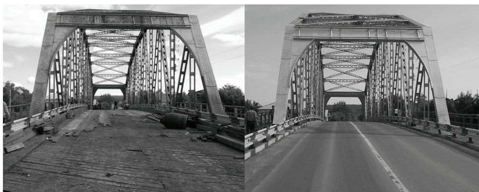
Рис. 6. Вид проезжей до и после реконструкции
