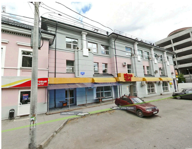
Рис. 4. Фасад дома на ул. Пермской
