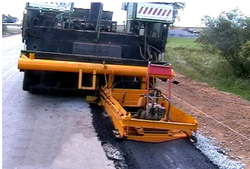
Рис. 3. Испытание агрегата для изготовления прикромочных водоотводных лотков из асфальтобетона
