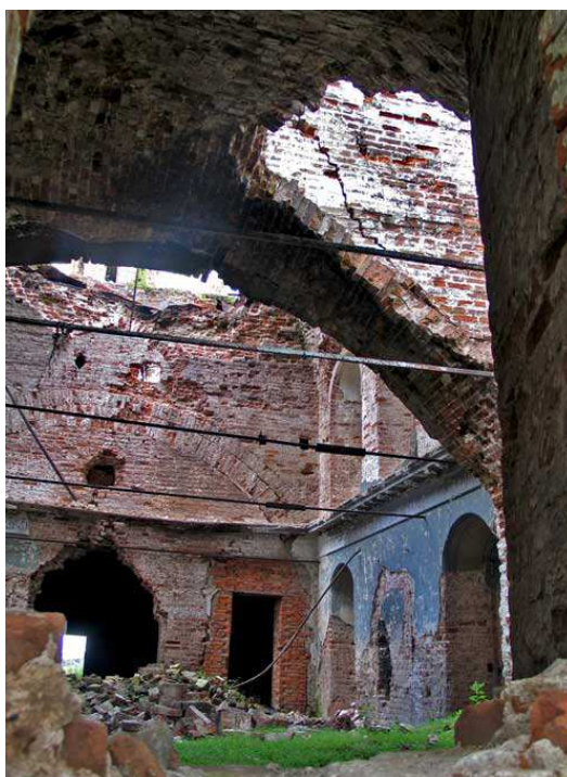
Рис. 2. Церковь Владимирской Божьей Матери в г. Усолье Пермского края. Объект культурного наследия федерального значения
