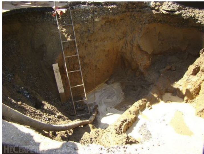
Рис. 1. Аварии на водоводе в г. Перми: а – ул. Куйбышева; б – ул. Островского
