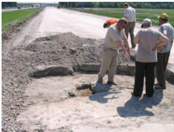
Рис. 2. Ремонт цементобетонной автомобильной дороги
