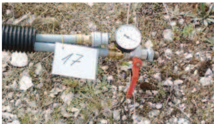
Рис. 6. Установка контрольного оборудования
